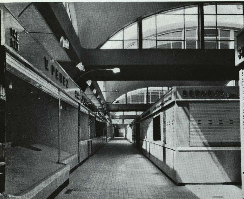
de 8 centímetros en la clave hasta 15 centímetros en el arranque. Estas bóvedas apoyan en la estructura perimetral y en el interior, en dos parejas de soportes gemelos, siendo el peso de cada una de 200 toneladas aproximadamente. Las bóvedas van separadas entre sí por cuatro grandes ventanales, que permiten establecer una gran iluminación en el interior.
